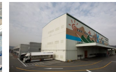
삼양패키징 대전1, 2공장
